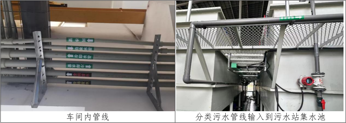
图4.3-11企业排污管线架空情况
