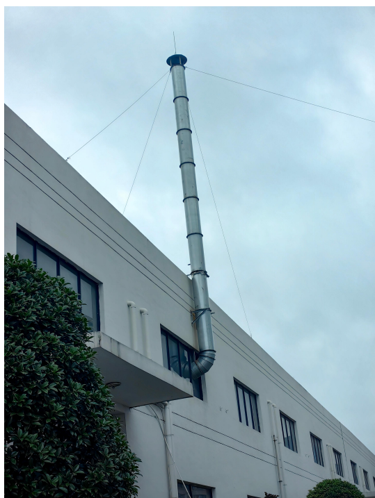
干式过滤+二级活性炭吸附处理后尾气 15m 高排气筒(DA015)排放
