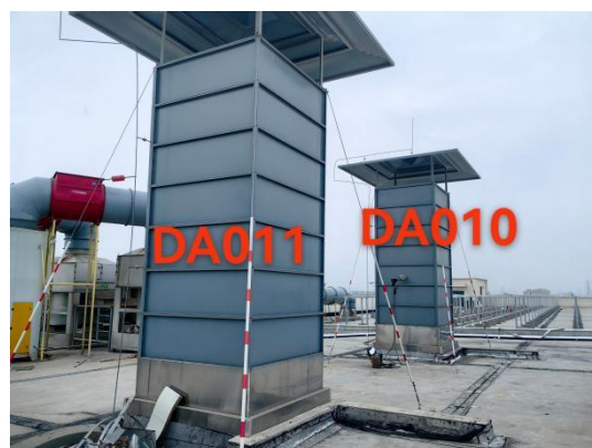
成品车间打磨粉尘废气处理设施 DA008、DA009、DA010、DA011
