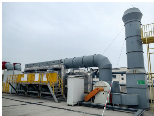
南侧两间喷房内喷漆废气（含面漆调配、喷漆、喷枪清洗废气）、晾干废气处理设施 DA013
