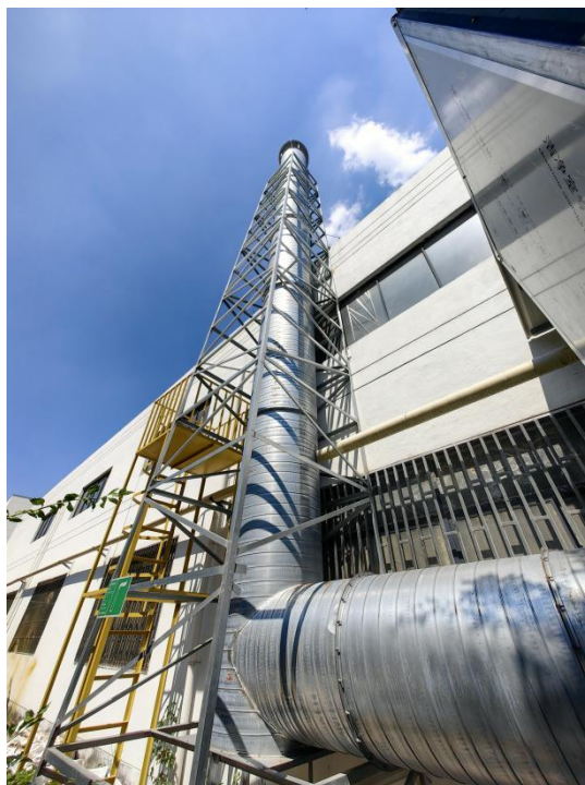
涂泥砂光废气、涂泥工序搅拌废气处理设施 DA002
