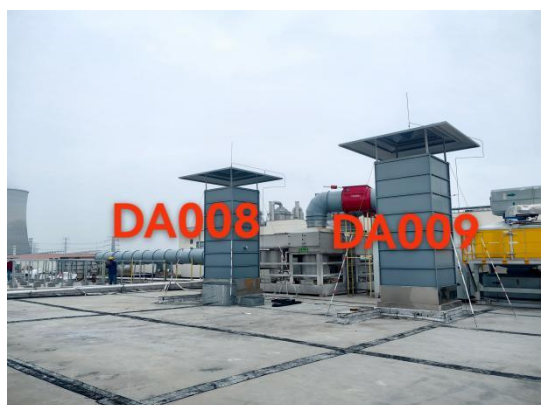
成品车间打磨粉尘废气处理设施 DA008、DA009、DA010、DA011
