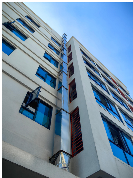
南侧两间喷房内喷漆废气（含面漆调配、喷漆、喷枪清洗废气）、晾干废气处理设施 DA013
