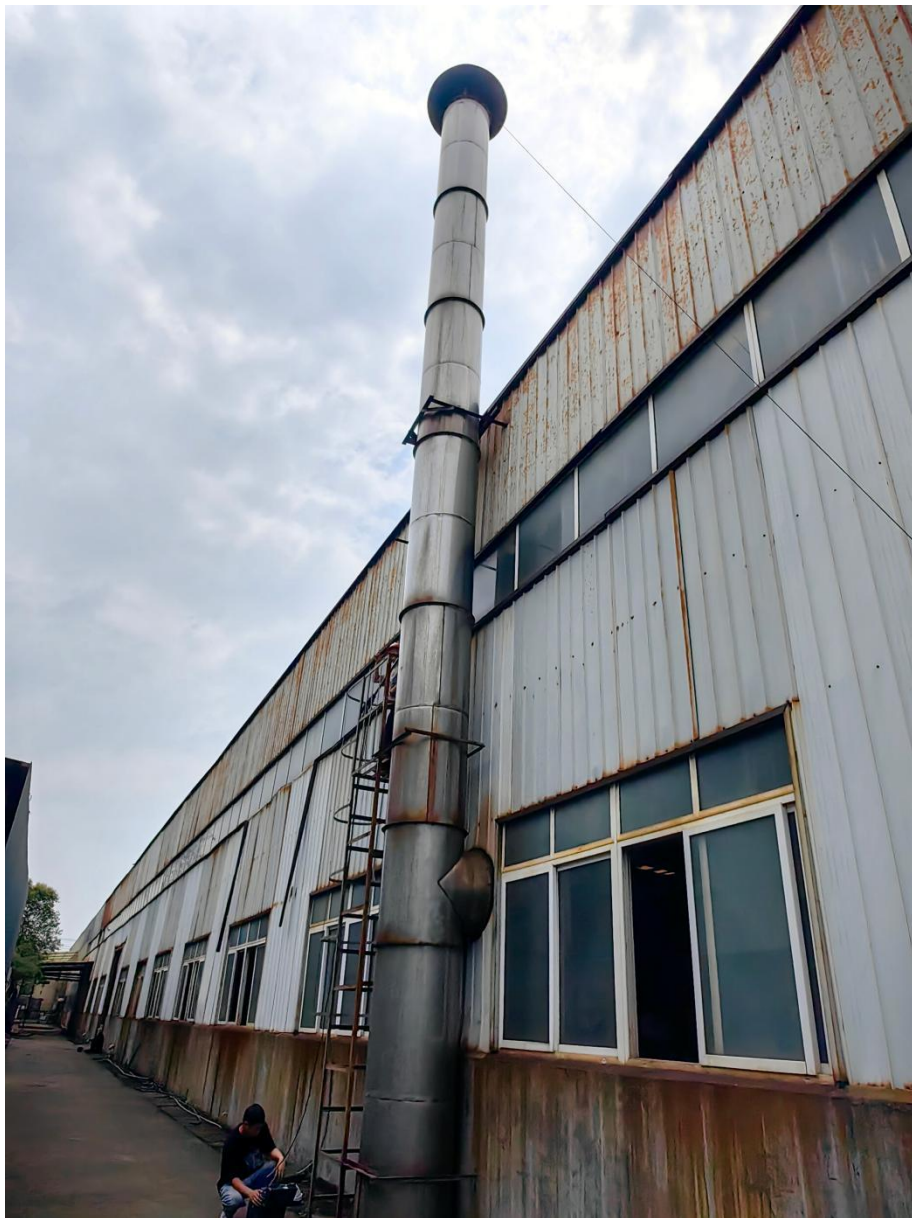
退火炉废气、天然气燃烧废气处理设施（二级水喷淋+除油吸附+塑烧板除尘）
